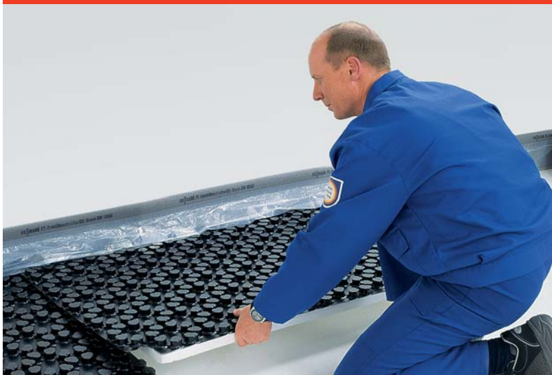
Obr. 5: Spojení nopových prvků
