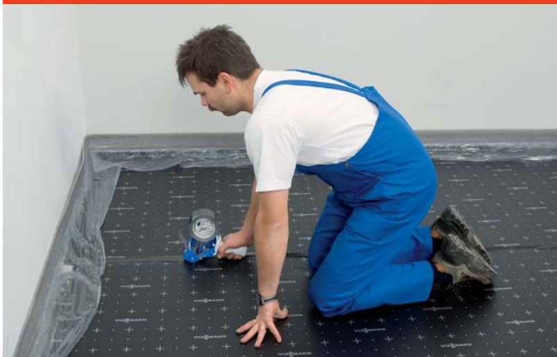
Obr. 16: Překrytí lepicí páskou
