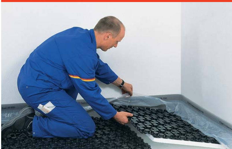
Obr. 6: Nopový prvek nařežte „na míru“
