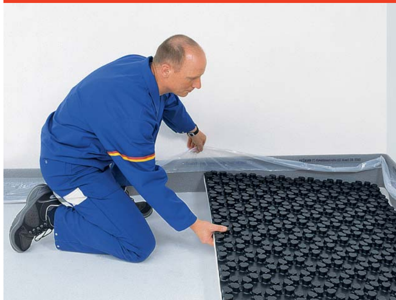
Obr. 4: Pokládka nopového prvku
