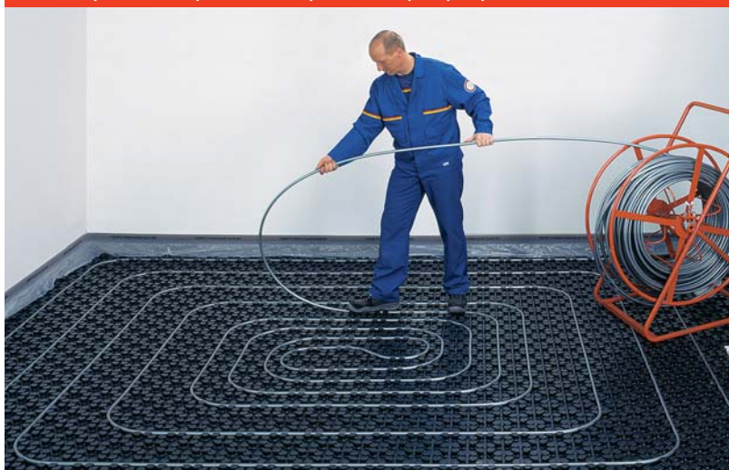
Obr. 9: Topnou trubku systému Vitoset položte na nopové prvky
