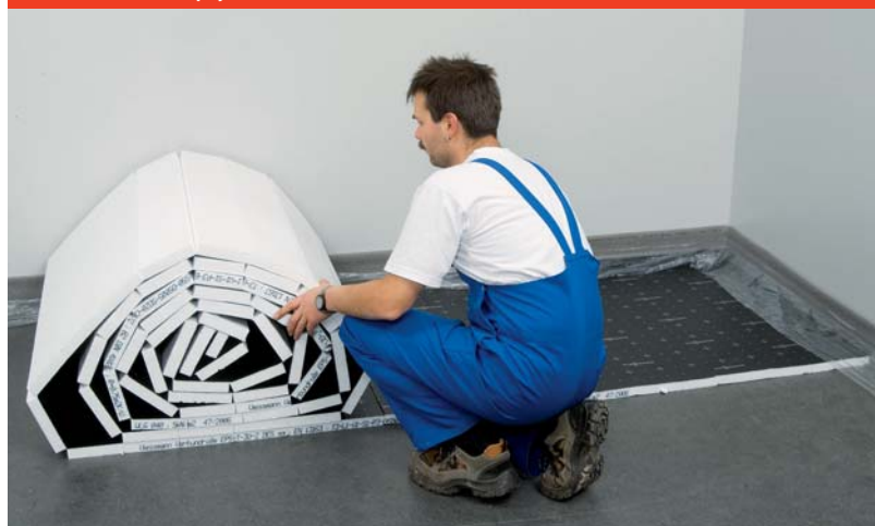
Obr. 15: Pokládka spojovacího materiálu
