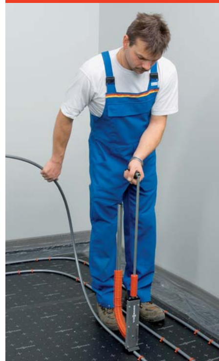
Obr. 17: Kotvicí sponky trubky těsně obepnou
