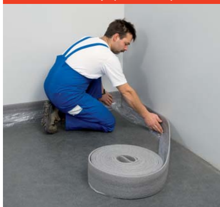
Obr. 14: Pokládka okrajových izolačních pásů
