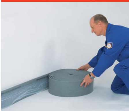
Obr. 2: Pokládka okrajového izolačního pásu
