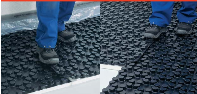
Obr. 7: Spojování přesahů nopových desek
