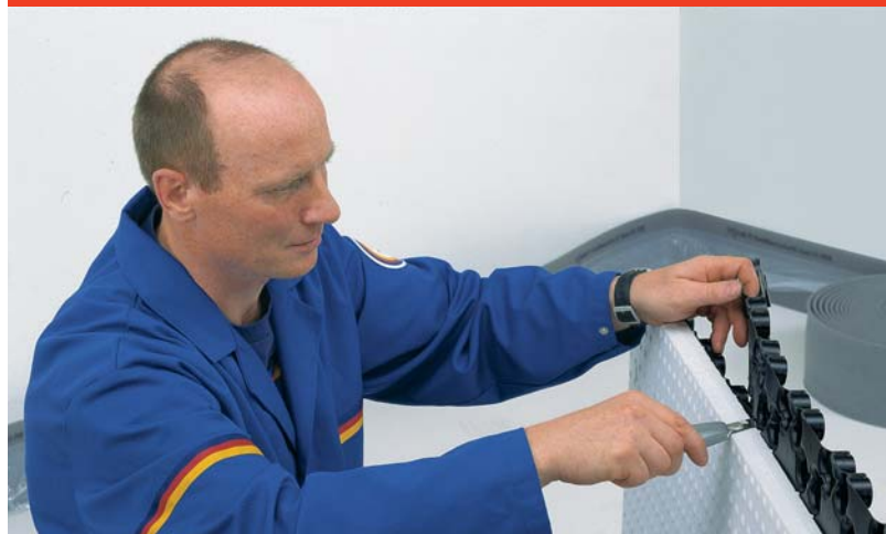
Obr. 3: Fóliový přesah nopového prvku je nutné odřeznout
