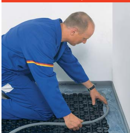
Obr. 8: Pokládka kruhového PE-profilu
